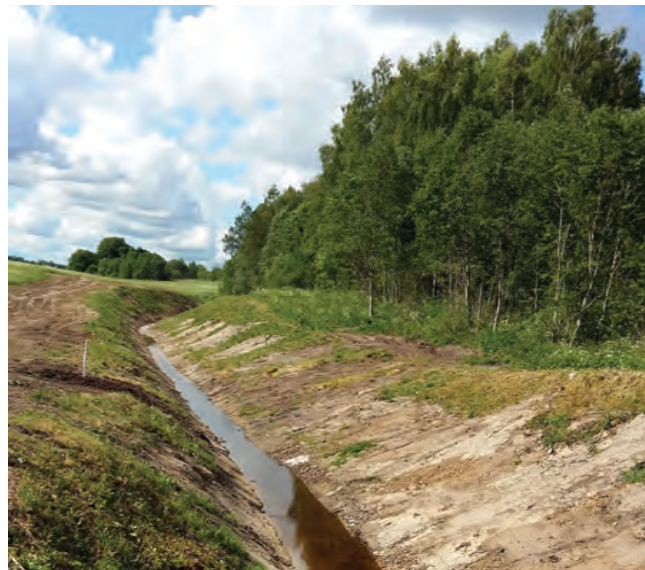
Griovys po remonto darbų
